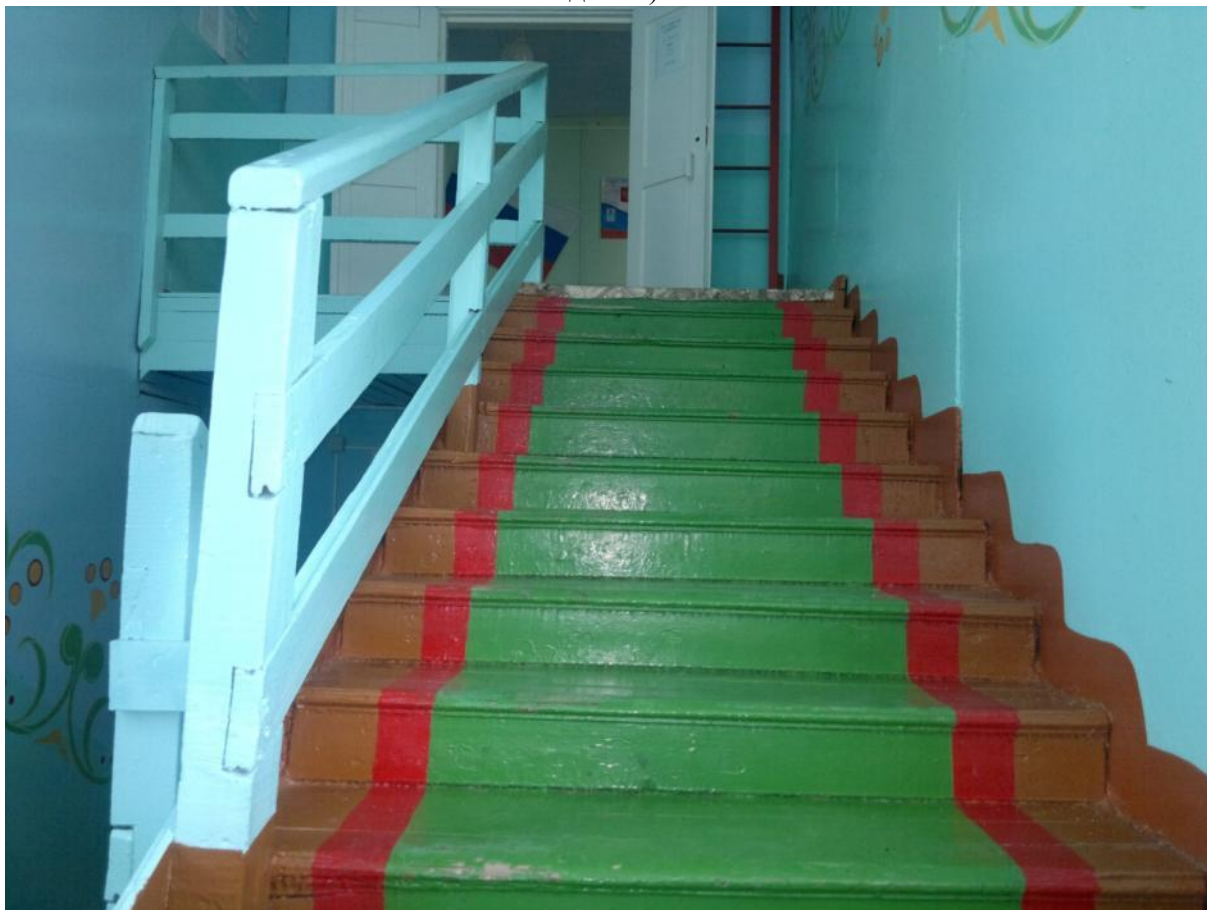
№3 (В) - Путь (пути) движения внутри здания (в т.ч. пути эвакуации), лестница (внутри здания)
